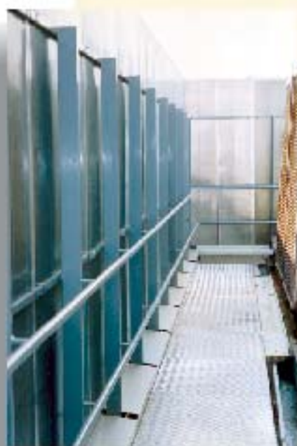
Condizionamento. Barriera acustica per gruppi frigoriferi. Air conditioning. Acoustic barriers for refrigeration units.
